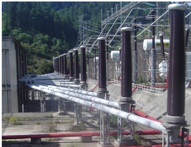
Figura 3.14 Líneas aisladas en gas.
